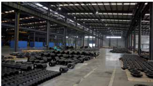
Вид завода изнутри
